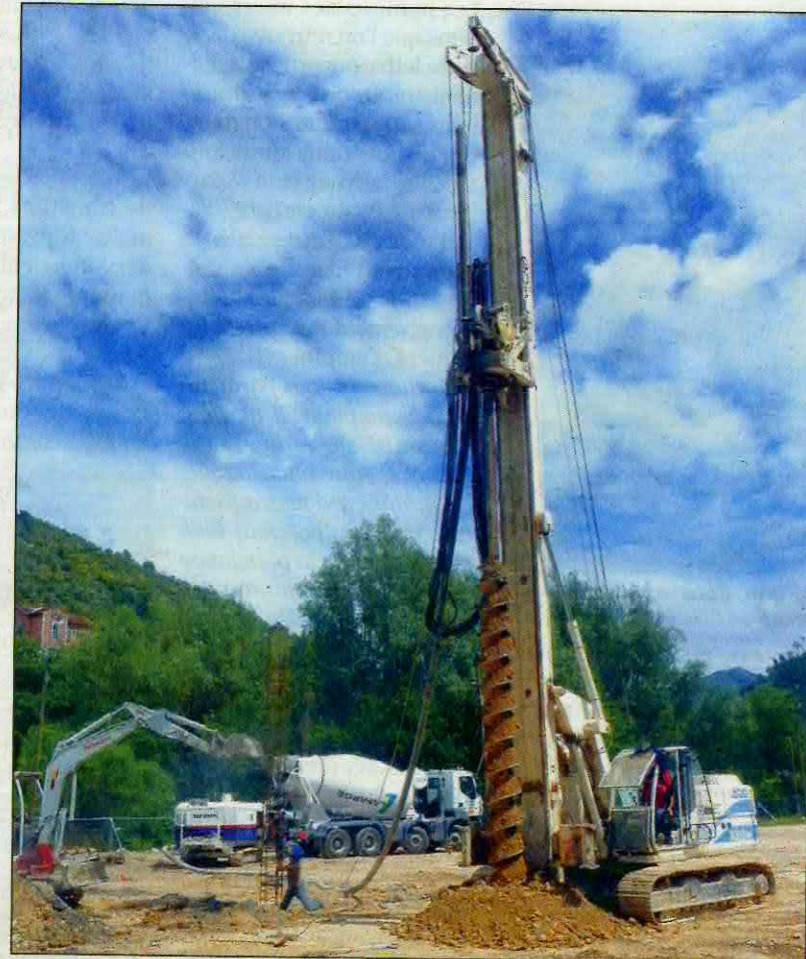
Sur place, 44 pieux de 3 à 7 mètres de profondeur sont nécessaires à la mise en place des fondations.
